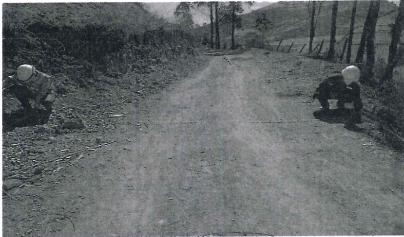
Fotografía N° 3: Replanteo de medidas del ancho del camino vecinal.
