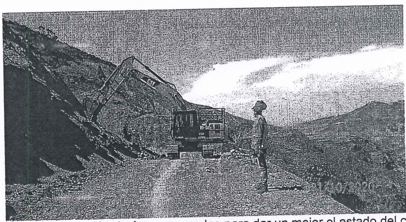
Fotografía N° 19: Recuperación de áreas ocupadas para dar un mejor el estado del camino vecinal Progresiva km 05+750. Coordenadas: 735362.18E, 9186720.08N
