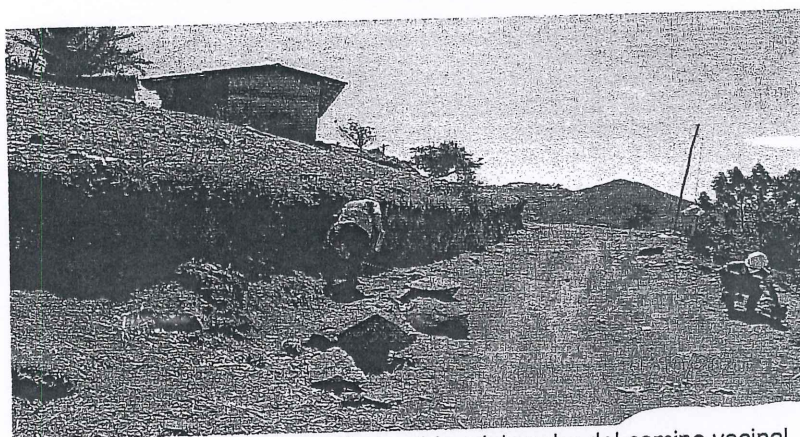
Fotografía N° 9: Replanteo de medidas del ancho del camino vecinal. Progresiva KM 10 + 000 Coordenadas: 731925.91E, 9188003.20 N
