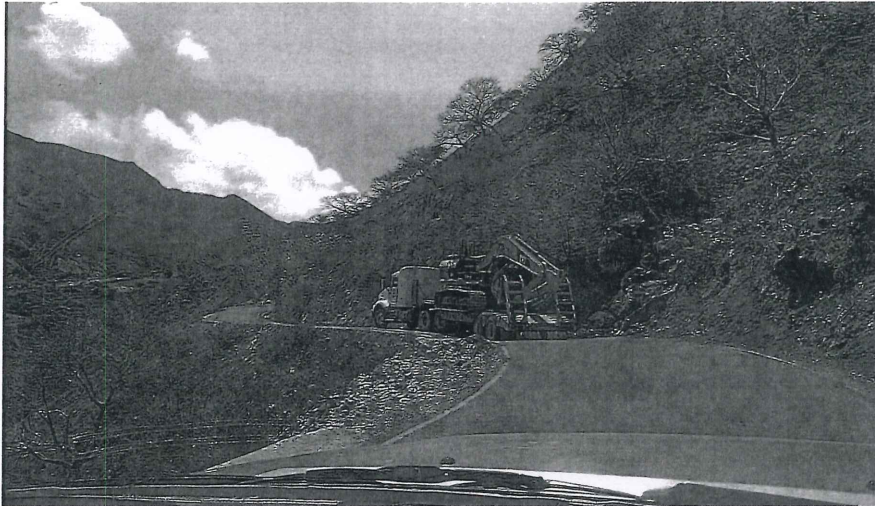
Fotografía N° 1: Movilización de excavadora 320 2L CAT desde Cajamarca a la obra.
