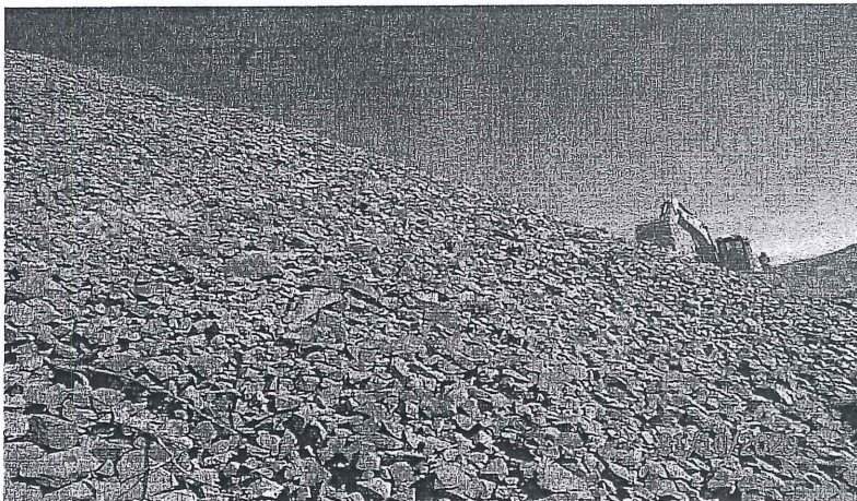
Fotografía N° 15: Acumulación y Apilamiento de material en cantera del señor Santos Medina Progresiva KM 5+354.72 Coordenadas: 735380.92E 9186457.01N.
