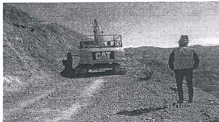
Fotografía N° 18: Recuperación de áreas ocupadas para dar un mejor el estado del camino vecinal Progresiva km 05+125. Coordenadas: 735401.23E, 9186541.17N.
