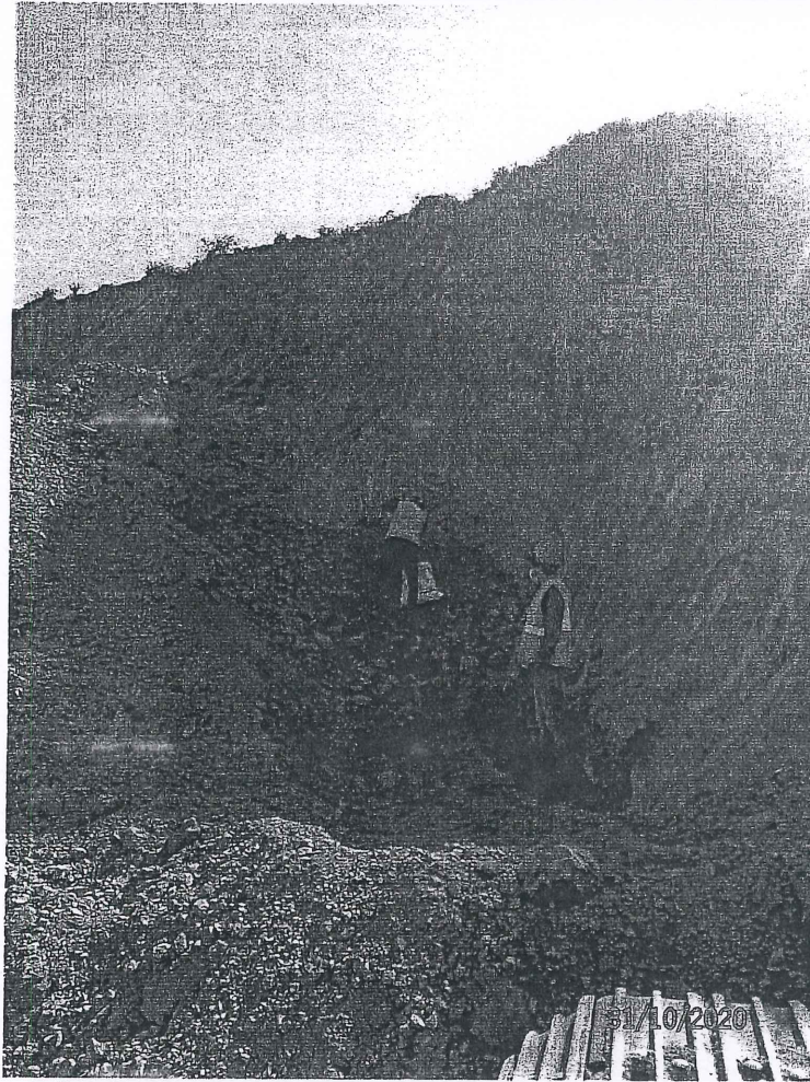
Fotografía N° 135: Extracción de material para ser analizado en laboratorio. Progresiva KM 5+354.72 Coordenadas: 735380.92E 9186457.01N.
