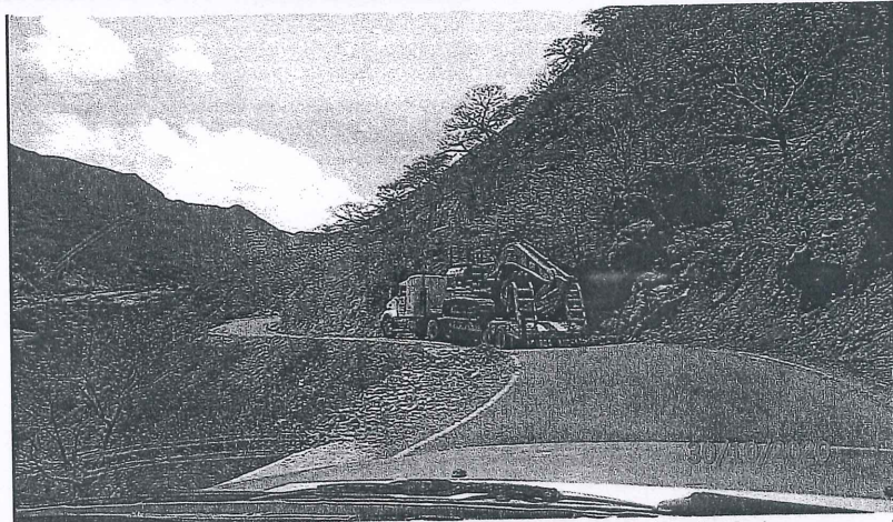
Fotografía N° 1: Movilización de excavadora 320 2L CAT desde Cajamarca a la obra. Coordenadas: 739196.72 E, 9197312.26 N
