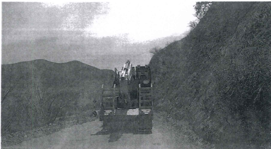
Fotografía N° 2: Movilización de excavadora 320 2L CAT desde Cajamarca a la obra.
