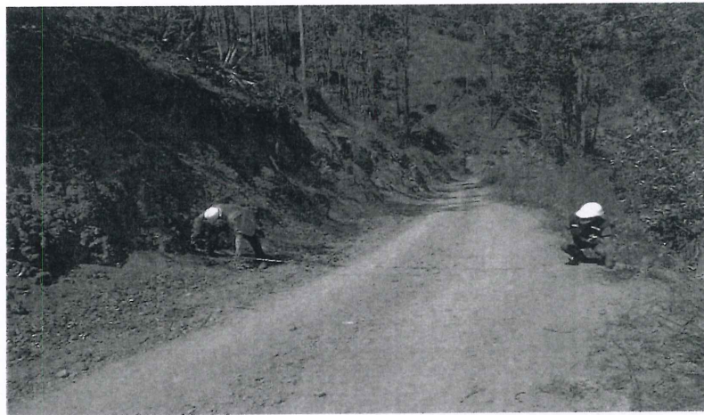
Fotografía N° 4: Replanteo de medidas del ancho del camino vecinal.
