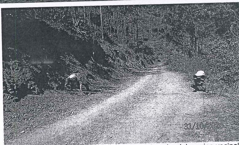
Fotografía N° 7: Replanteo de medidas del ancho del camino vecinal. Progresiva KM 10 + 250 Coordenadas: 733078.77 E, 9188628.69 N
